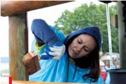
Każdy drewniany element został zabezpieczony bejcą
