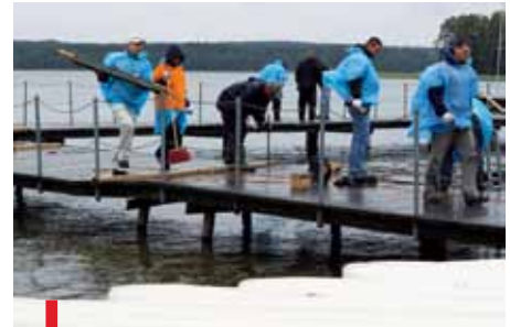
Na pomoście wymieniono spróchniałe deski. Pracy było naprawdę wiele
