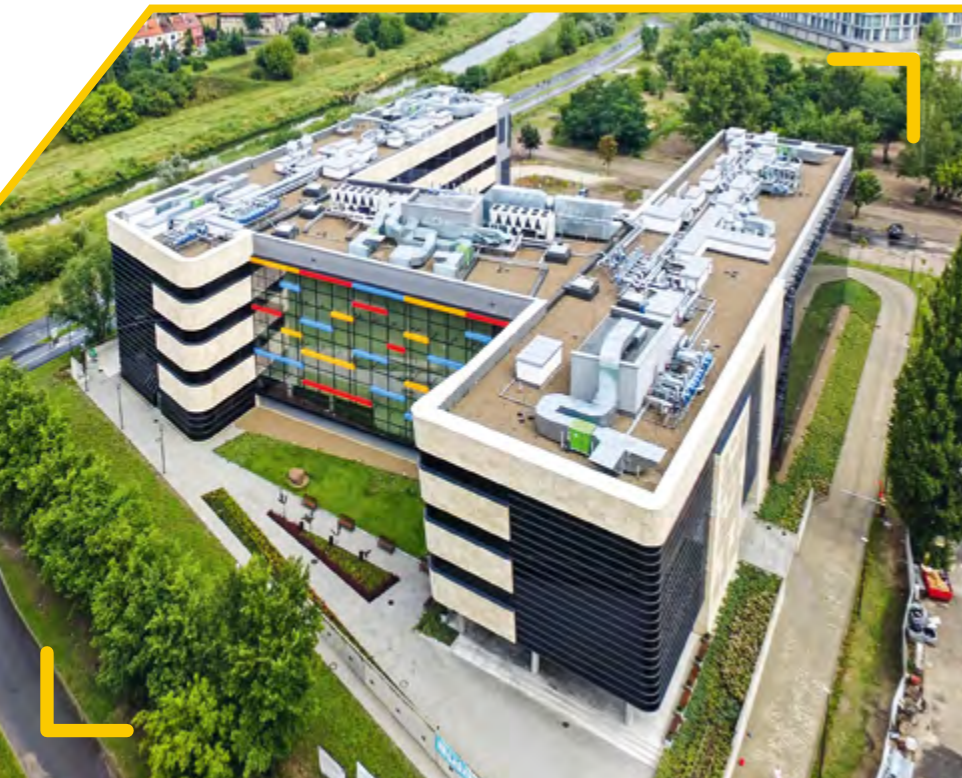
Centrum Dydaktyczne Wydziału Technologii Chemicznej Politechniki Poznańskiej
